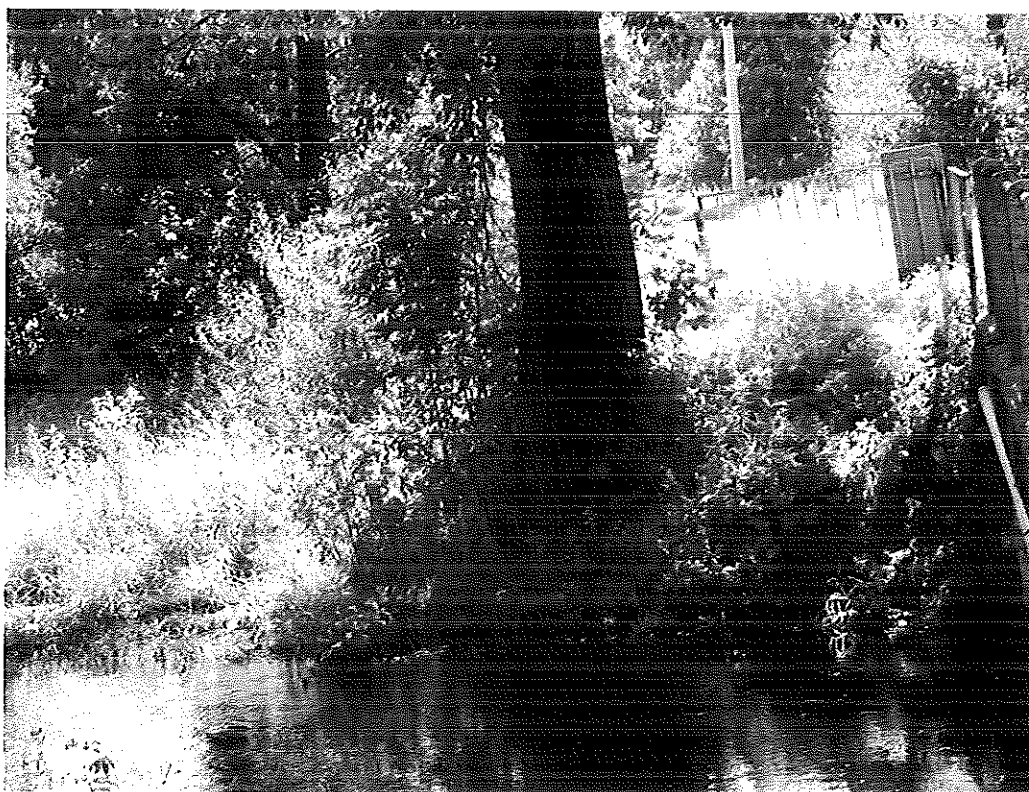
Fot. 6 Widok na lokalizację projektowanego przyczółka od strony miejscowości Majdan
