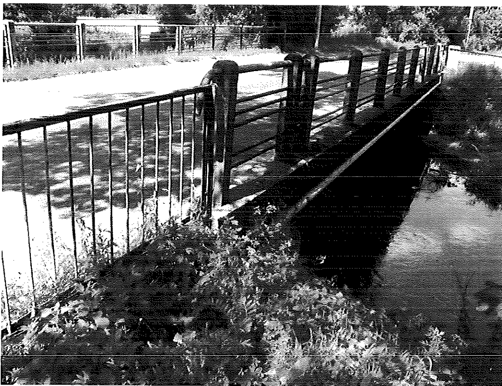
Fot. 2 Istniejący obiekt
