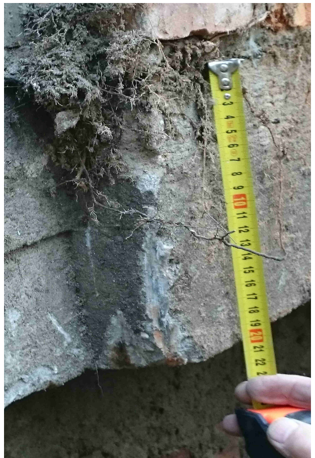
Foto. 54 Wieniec ściany fundamentowej - wysokość
