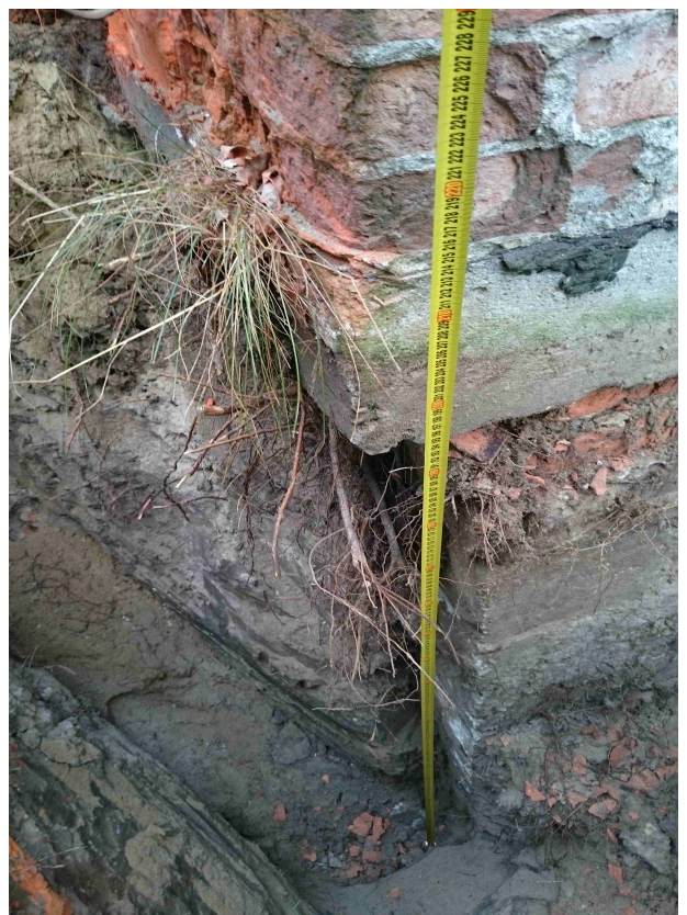
Foto. 49 Odkrywka fundamentu w narożu budynku
