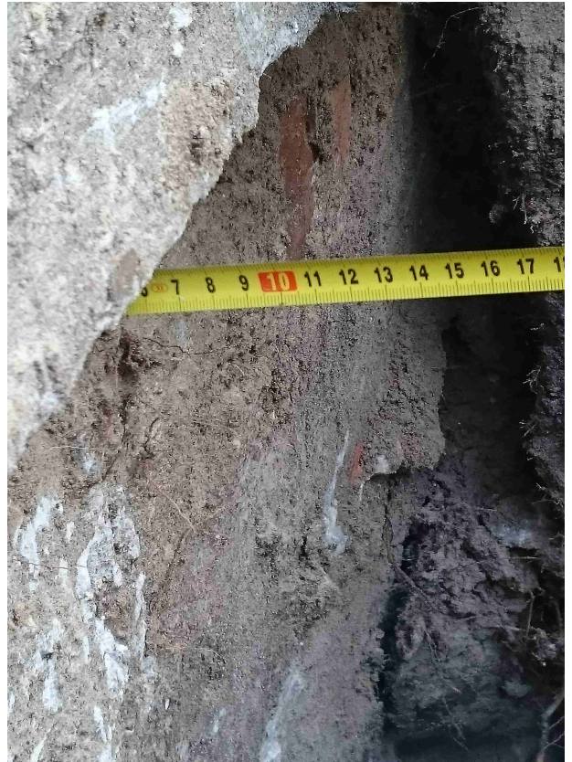
Foto. 53 Odsadzka ściany fundamentowej względem ściany osłonowej
