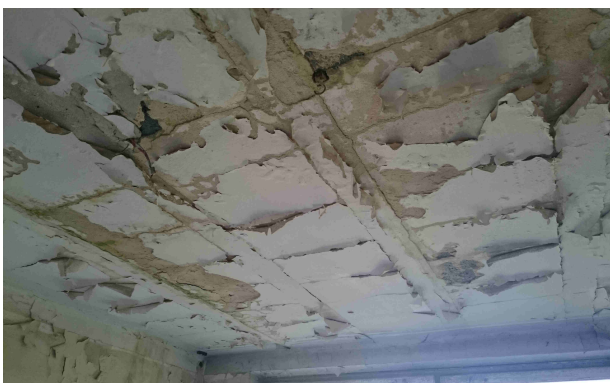
Foto. 5 Strop nad 2 piętrem – widok od spodu
