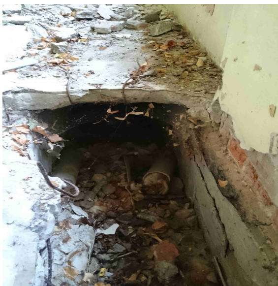
Foto. 38 Kanał instalacji c.o. pod posadzką
