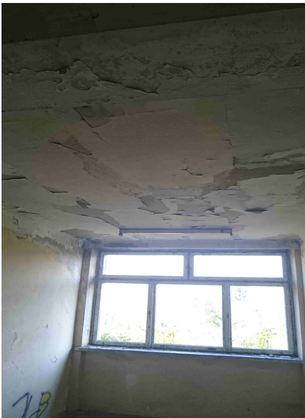
Foto. 8 Ściana osłonowa w klatce schodowej - widok
