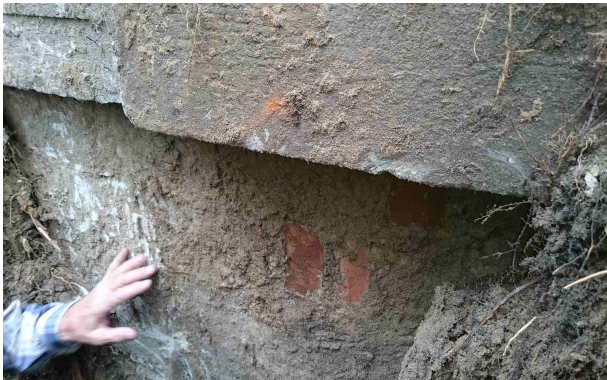
Foto. 51 Wieniec ściany fundamentowej - widok
