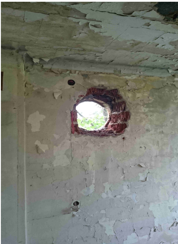
Foto. 1 Ściana osłonowa z otworem - widok
