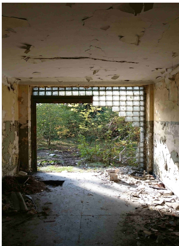
Foto. 30 Wejście do budynku – widok od korytarza
