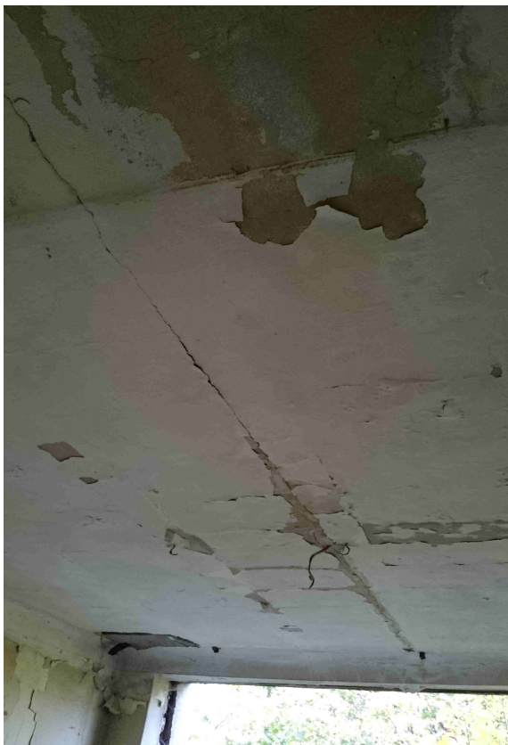
Foto. 23 Strop nad 1 piętrem – widok od spodu
