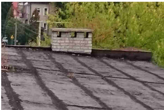
Foto. 46 Komin przy attyce - widok
