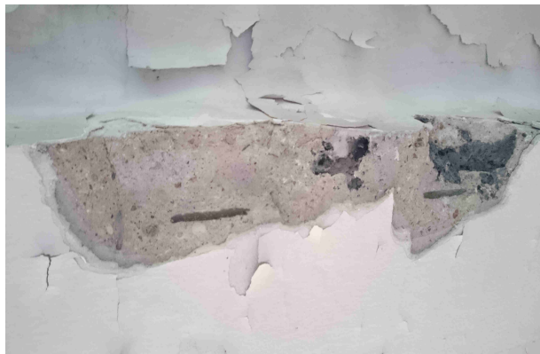
Foto. 57 Odkrywka zbrojenia podciągu w parterze
