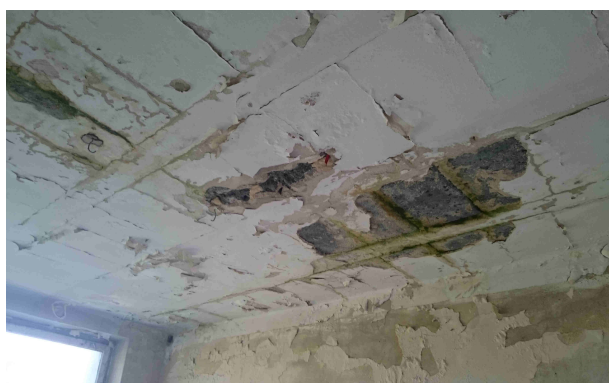
Foto. 6 Strop nad 2 piętrem – widok od spodu
