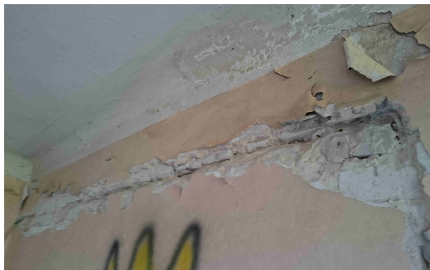
Foto. 9 Ściana wewnętrzna klatki schodowej - widok
