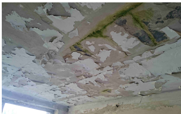
Foto. 7 Strop nad 2 piętrem – widok od spodu
