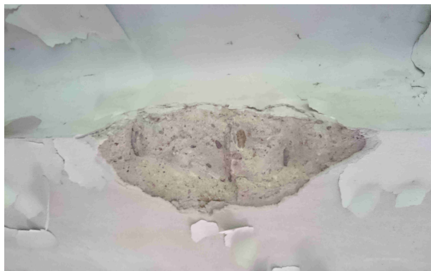
Foto. 56 Odkrywka zbrojenia podciągu w parterze
