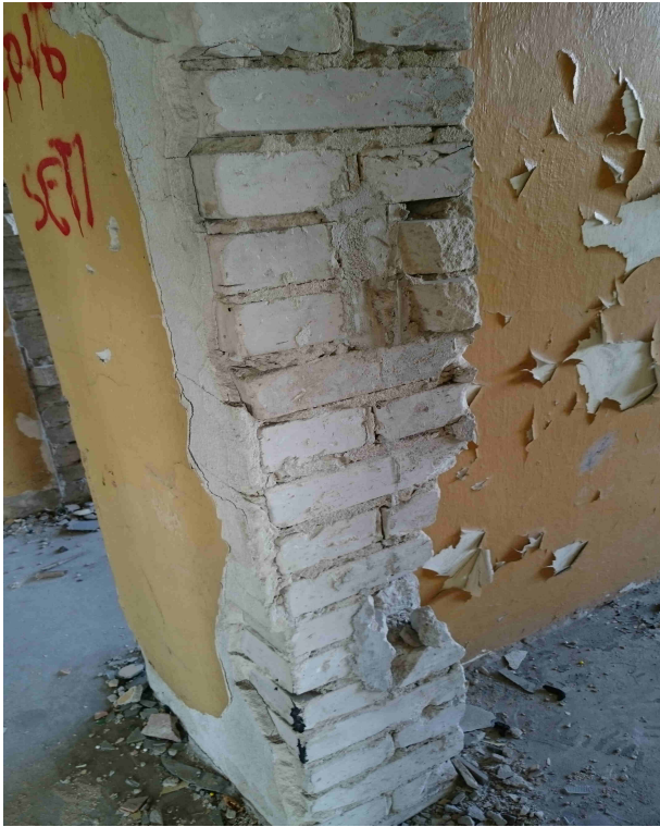
Foto. 14 Ściana wewnętrzna konstrukcyjna - widok
