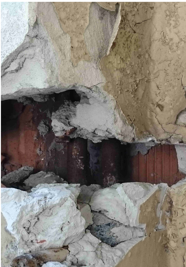
Foto. 28 Pion instalacyjny - widok
