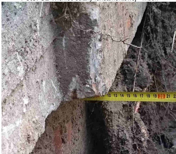
Foto. 52 Odsadzka ściany fundamentowej względem filara
