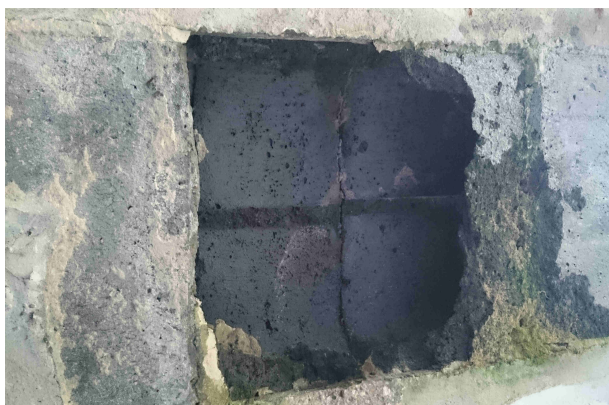
Foto. 3 Strop nad 2 piętrem – widok od spodu
