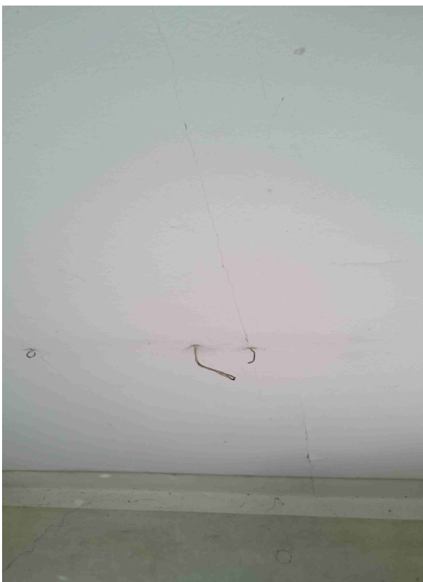
Foto. 21 Strop nad 1 piętrem – widok od spodu
