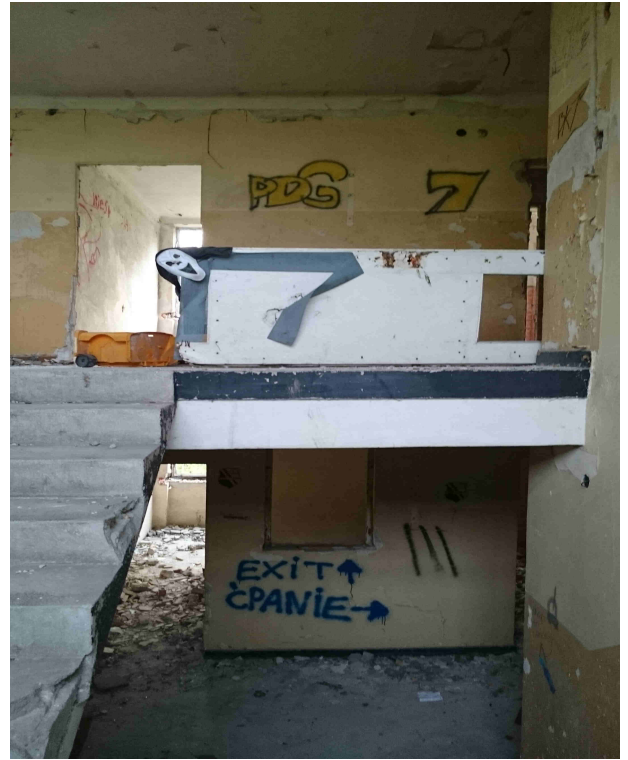
Foto. 40 Klatka schodowa - widok
