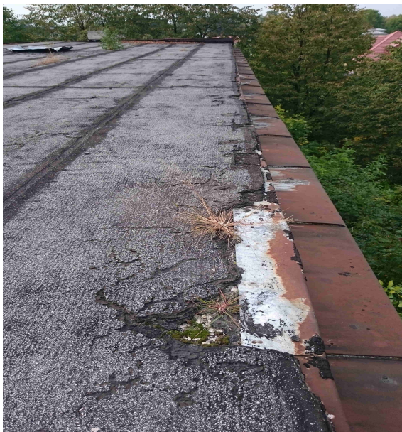
Foto. 42 Gzyms – obróbka gzymsu
