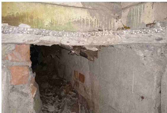
Foto. 35 Kanał instalacji c.o. pod posadzką
