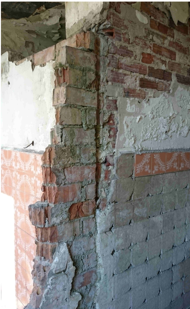
Foto. 16 Ściana działowa w pomieszczeniu sanitarnym
