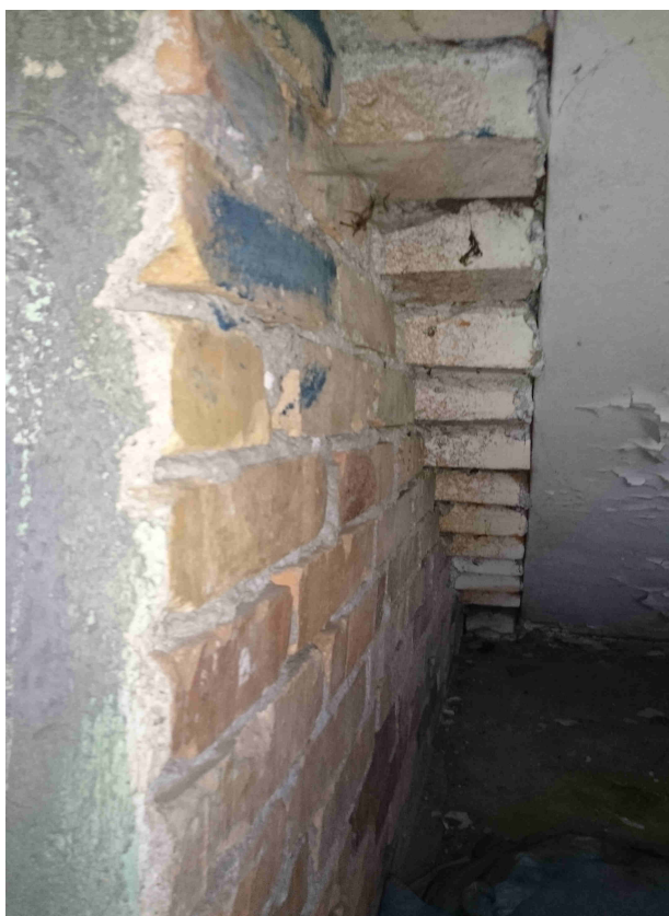
Foto. 37 Fragment biegu schodowego – widok od spodu
