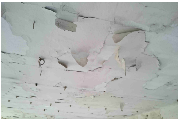
Foto. 33 Strop nad parterem – widok od spodu
