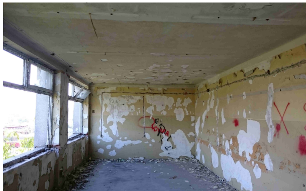
Foto. 10 Widok ścian pomieszczenia 2 piętra
