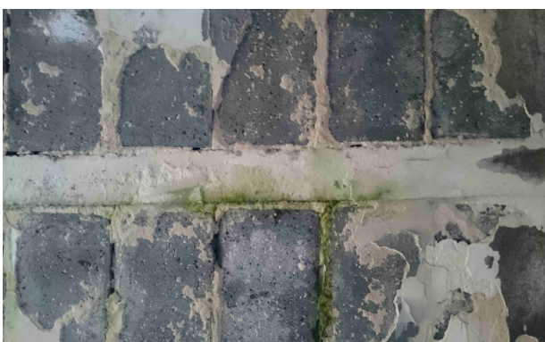
Foto. 4 Strop nad 2 piętrem – widok od spodu
