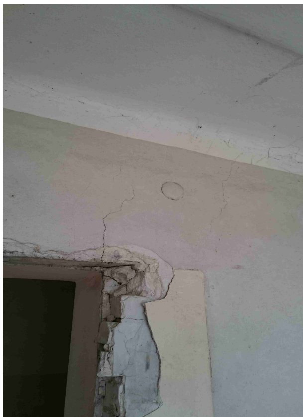
Foto. 22 Fragment ściany wewnętrznej z otworem drzwiowym
