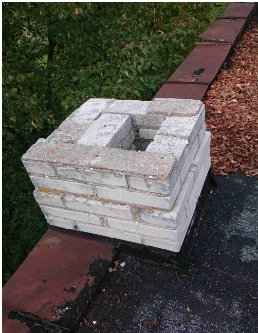
Foto. 45 Komin przy attyce - widok
