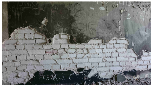
Foto. 24 Ściana wewnętrzna klatki schodowej- widok
