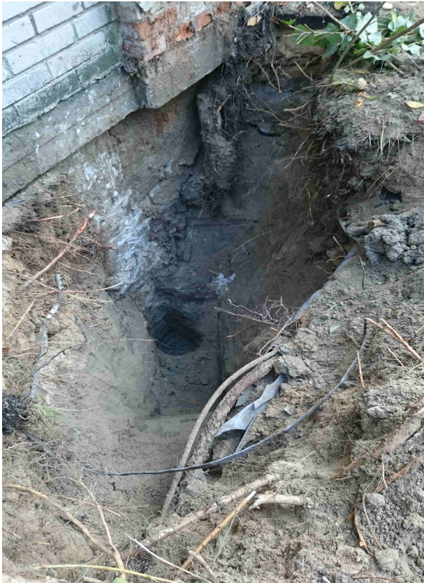
Foto. 50 Odkrywanie fundamentu
