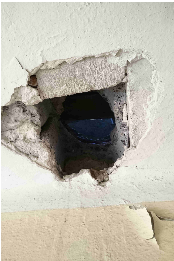
Foto. 11 Strop nad 2 piętrzem – widok od spodu
