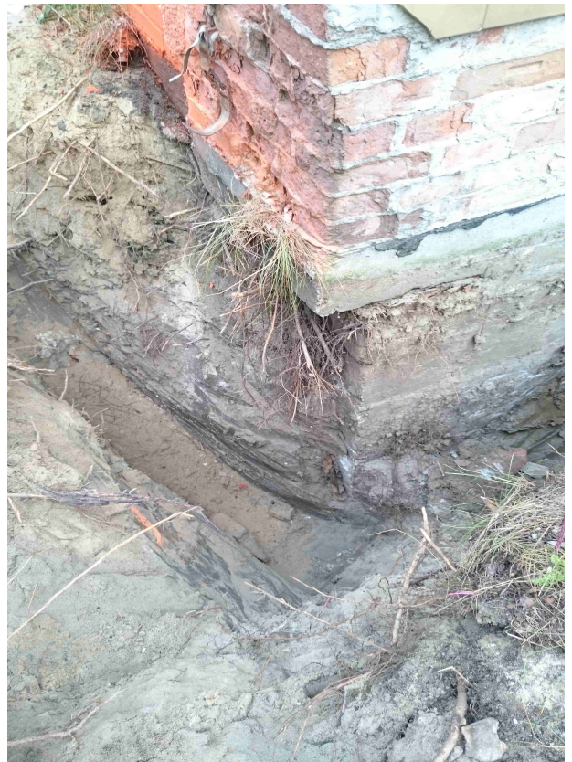
Foto. 48 Odkrywka fundamentu w narożu budynku
