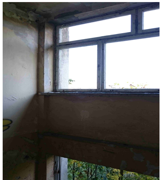
Foto. 18 Ściana osłonowa klatki schodowej - widok
