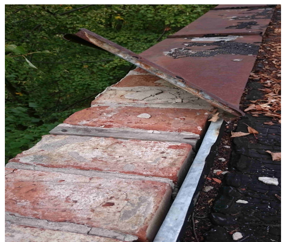
Foto. 44 Ściana attyki - widok
