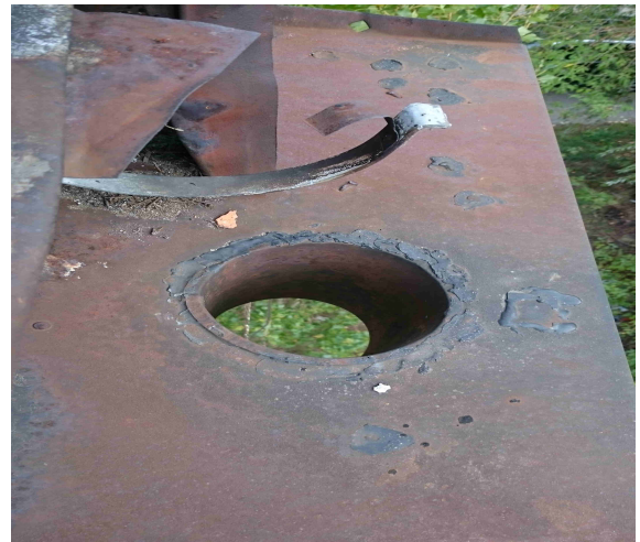
Foto. 43 Otwór w gzymsie pod rurę spustową
