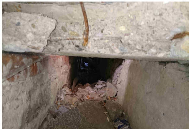
Foto. 32 Kanał instalacji c.o. pod posadzką
