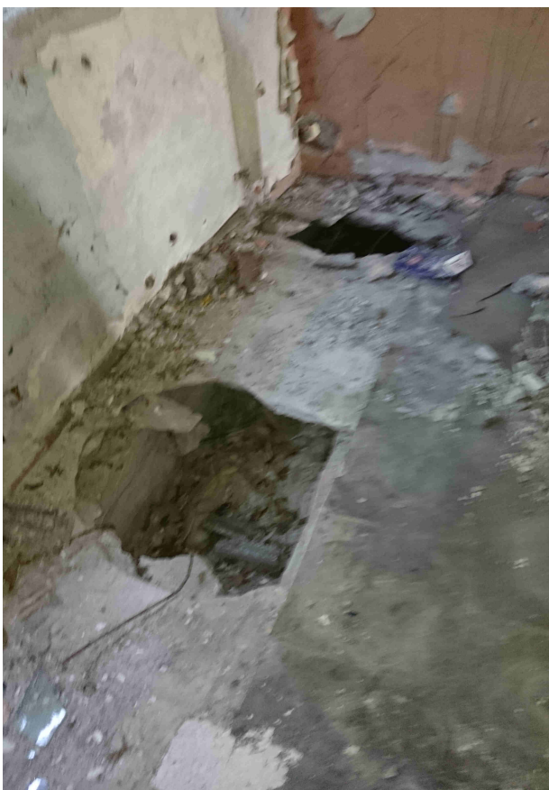
Foto. 31 Kanały instalacji c.o. pod posadzką
