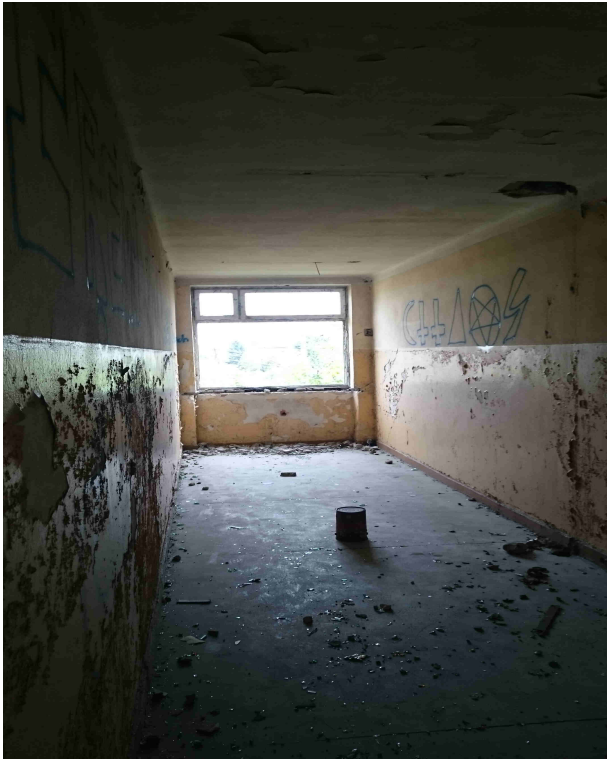
Foto. 39 Korytarz – widok ściany osłonowej
