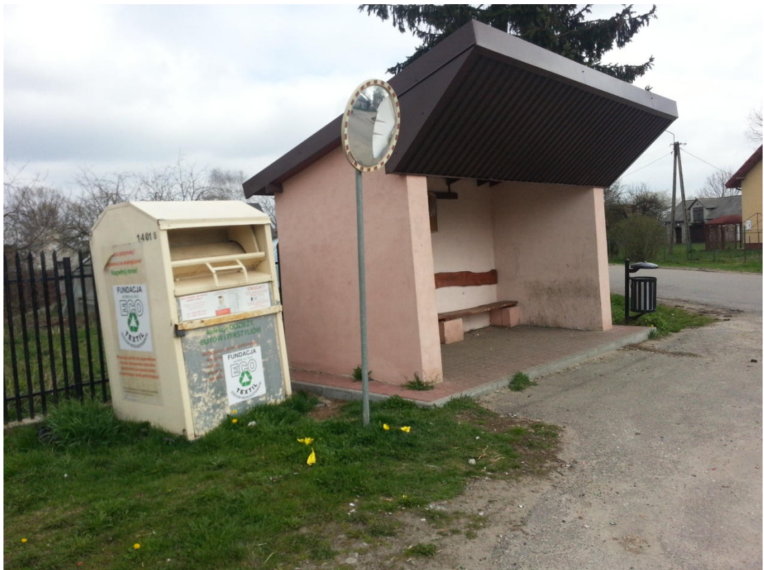
Rysunek 1 Wiaty autobusowa do rozbiórki.
