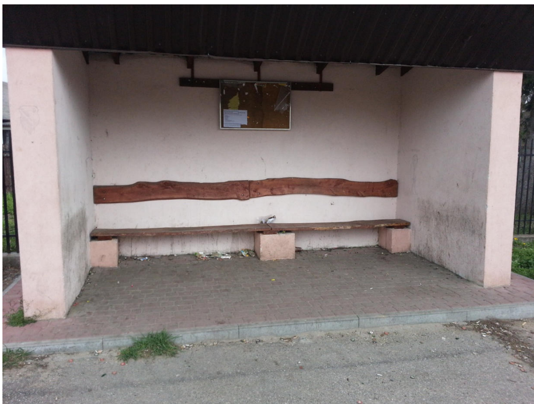
Rysunek 2 Wiata autobusowa do rozbiórki.
