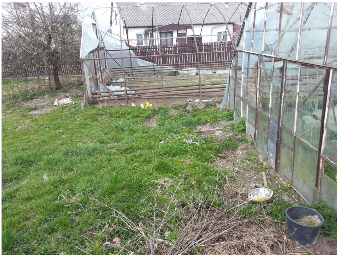
Rysunek 5 Część ciepłarni przeznaczona do rozbiórki.
