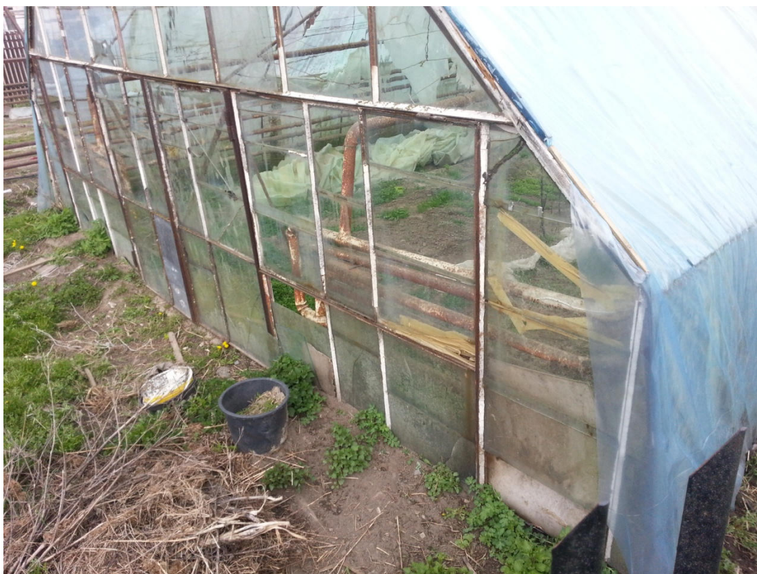
Rysunek 4 Ciepłarnia przeznaczona w całości do rozbiórki.
