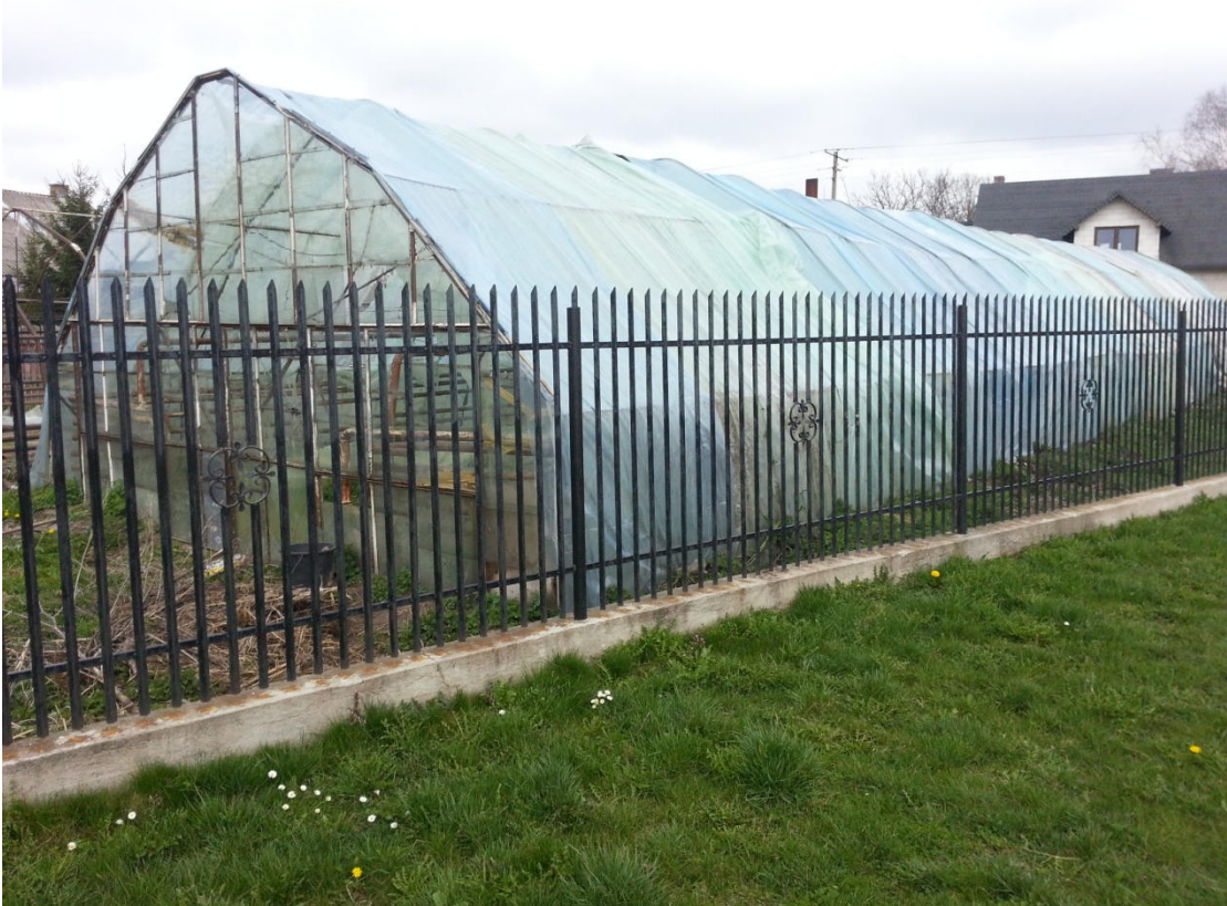
Rysunek 3 Ciepłarnia przeznaczona w całości do rozbiórki.
