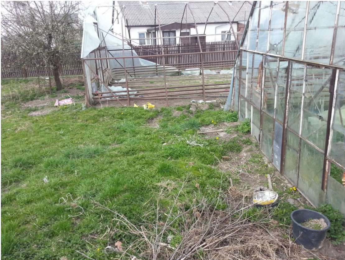
Rysunek 5 Część cieplarni przeznaczona do rozbiórki.
