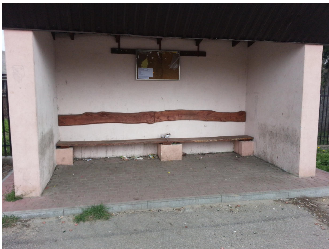
Rysunek 2 Wiata autobusowa do rozbiórki.
