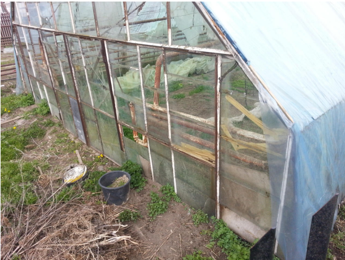
Rysunek 4 Ciepłarnia przeznaczona w całości do rozbiórki.
