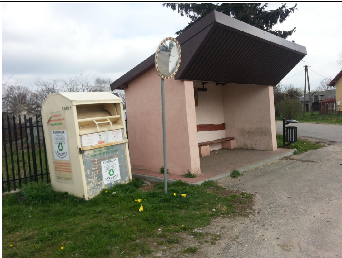
Rysunek 1 Wiata autobusowa do rozbiórki.
