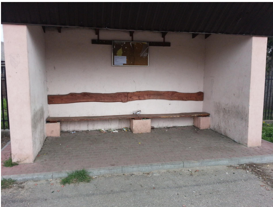
Rysunek 2 Wiata autobusowa do rozbiórki.
