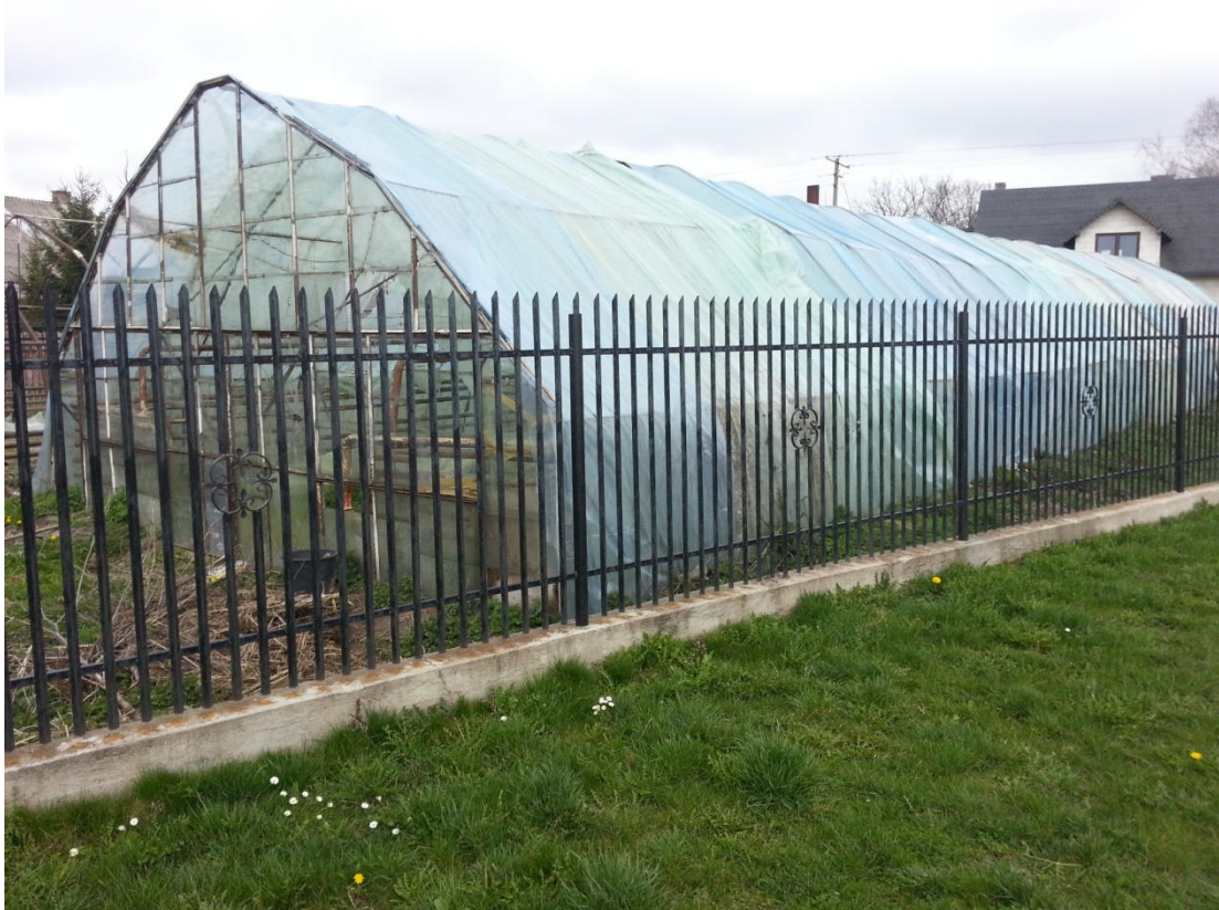
Rysunek 3 Ciepłarnia przeznaczona w całości do rozbiórki.
