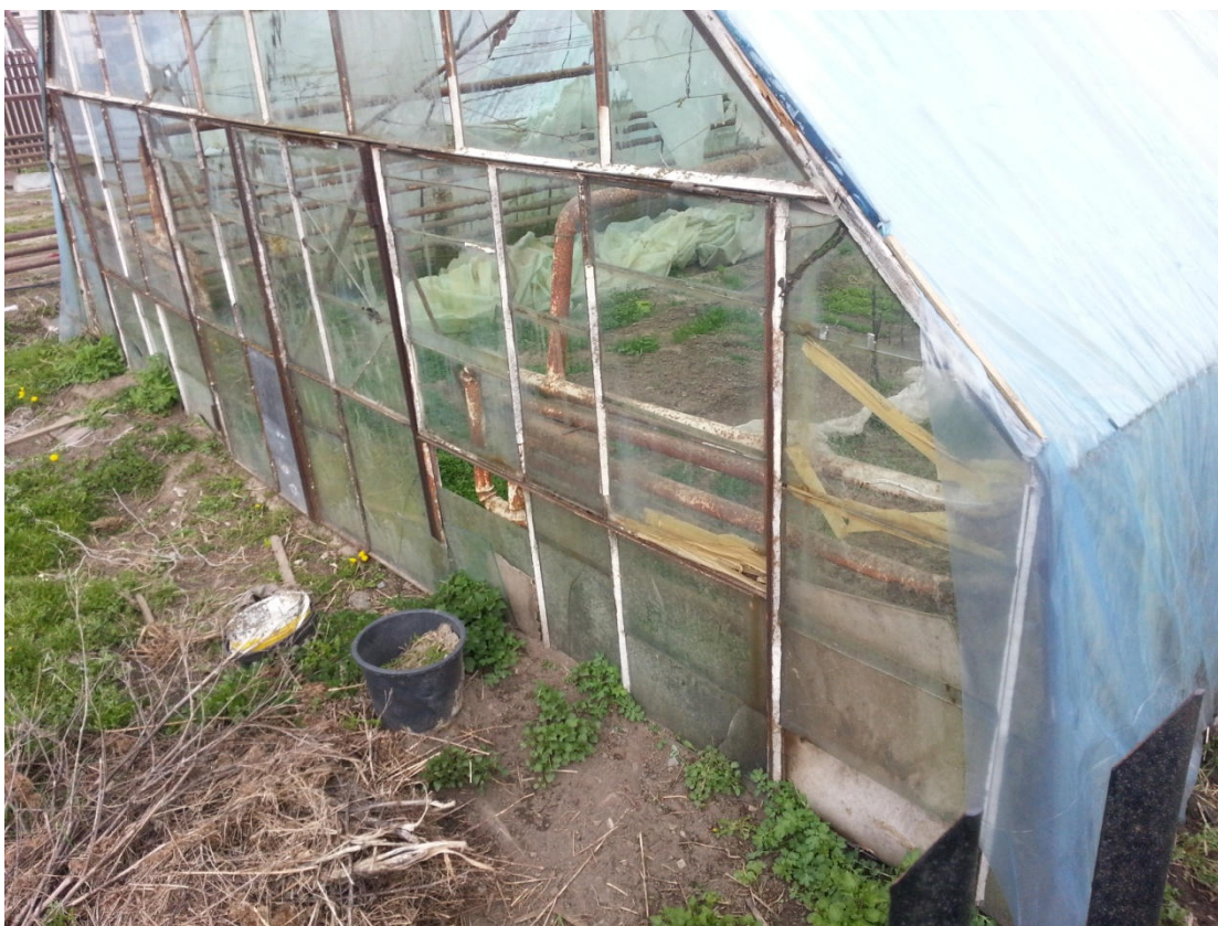
Rysunek 4 Ciepłarnia przeznaczona w całości do rozbiórki.
