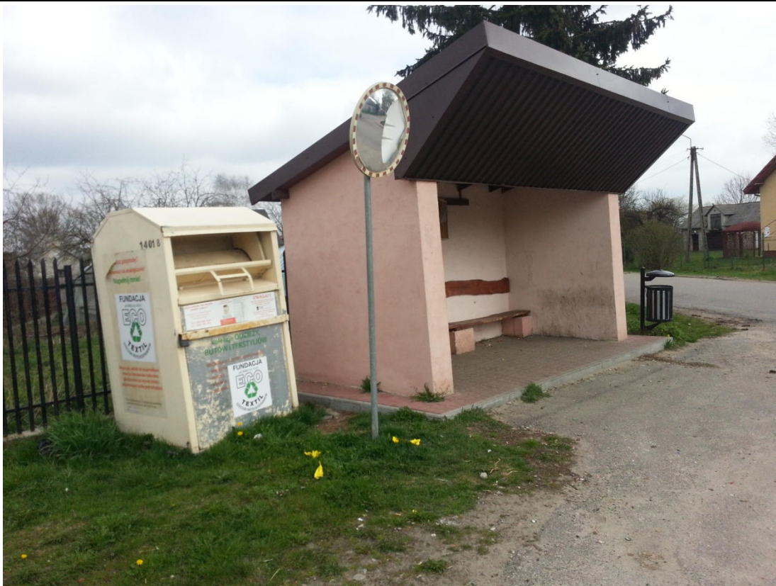
Rysunek 1 Wiata autobusowa do rozbiórki.
