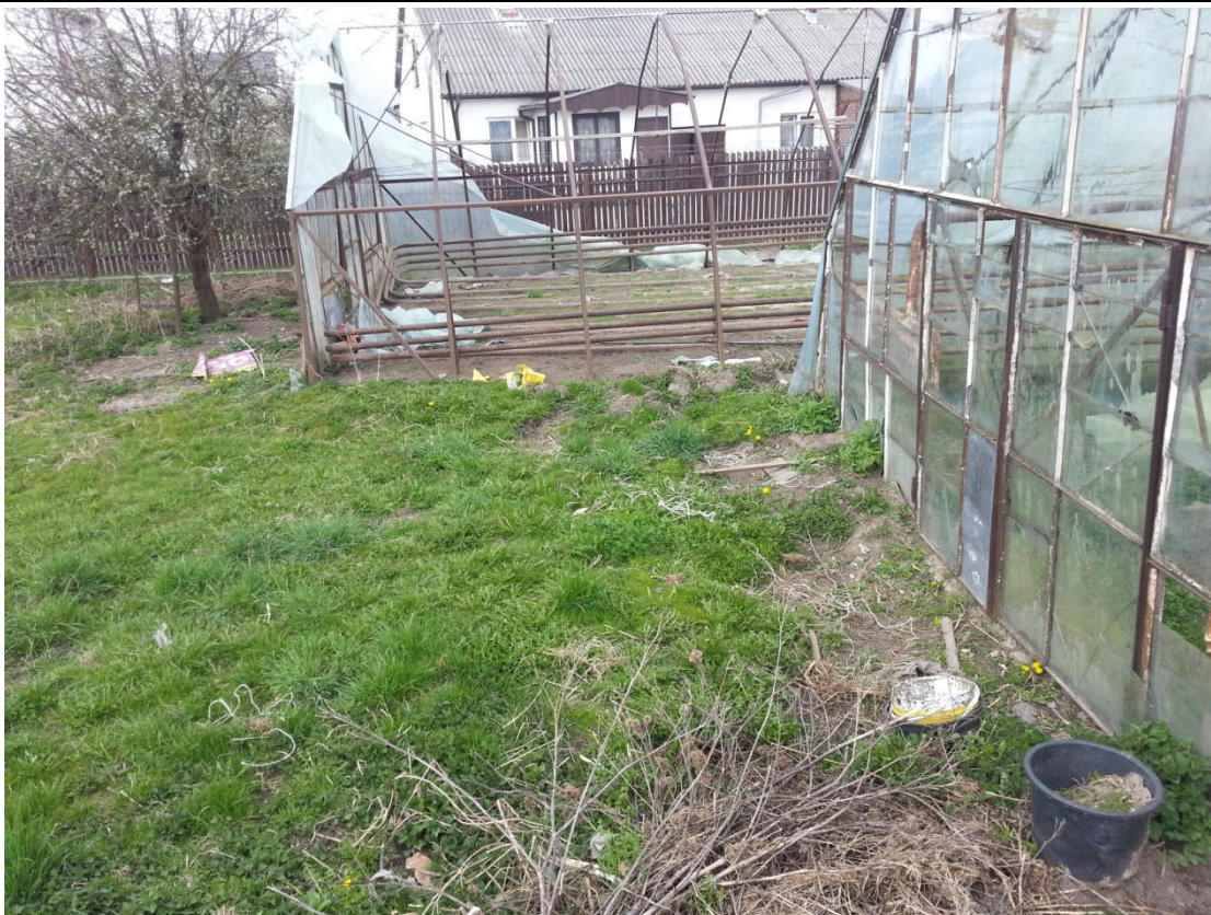
Rysunek 5 Część cieplarni przeznaczona do rozbiórki.
